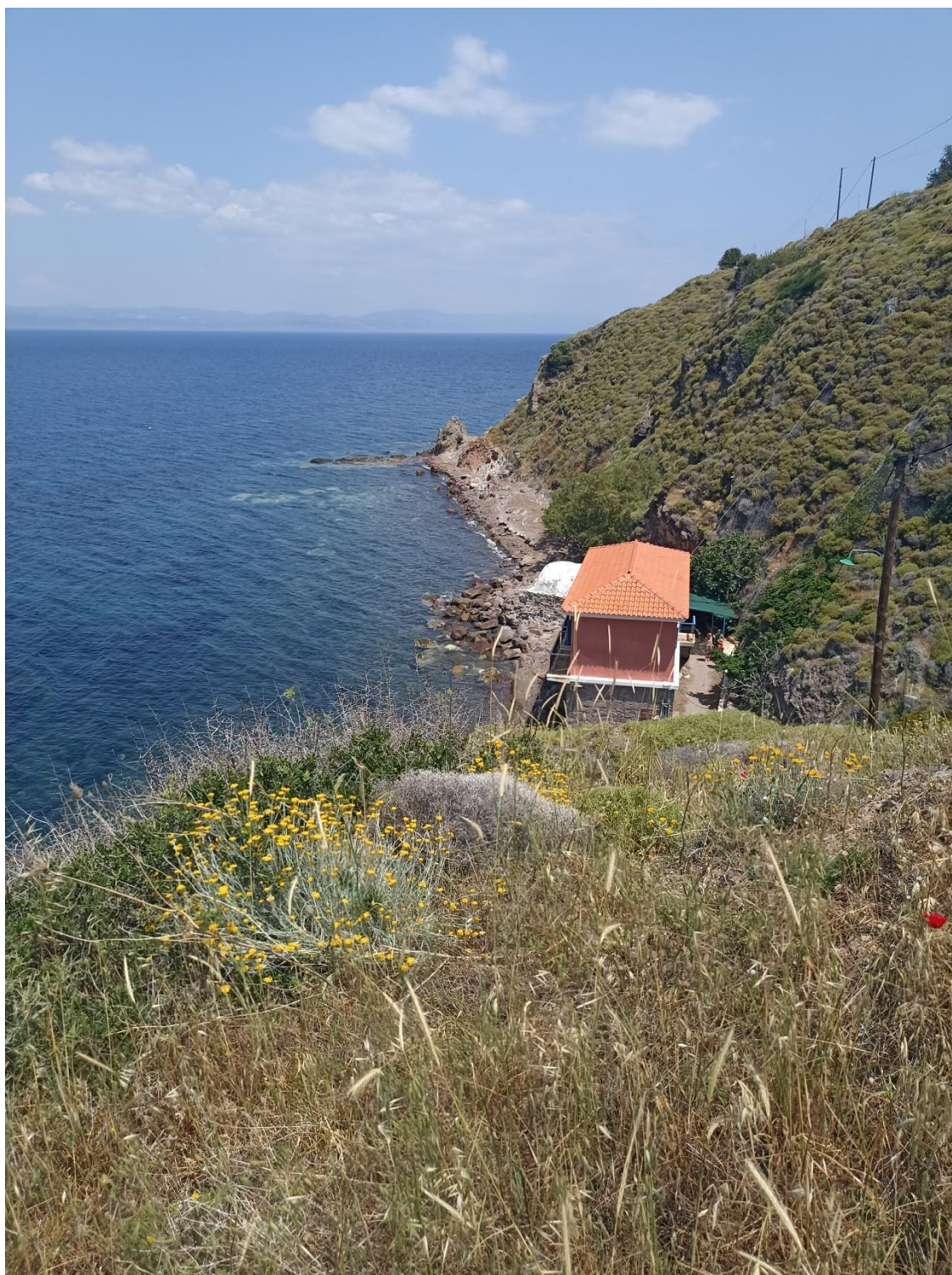
Οι εγκαταστάσεις από το δημοτικό δρόμο
