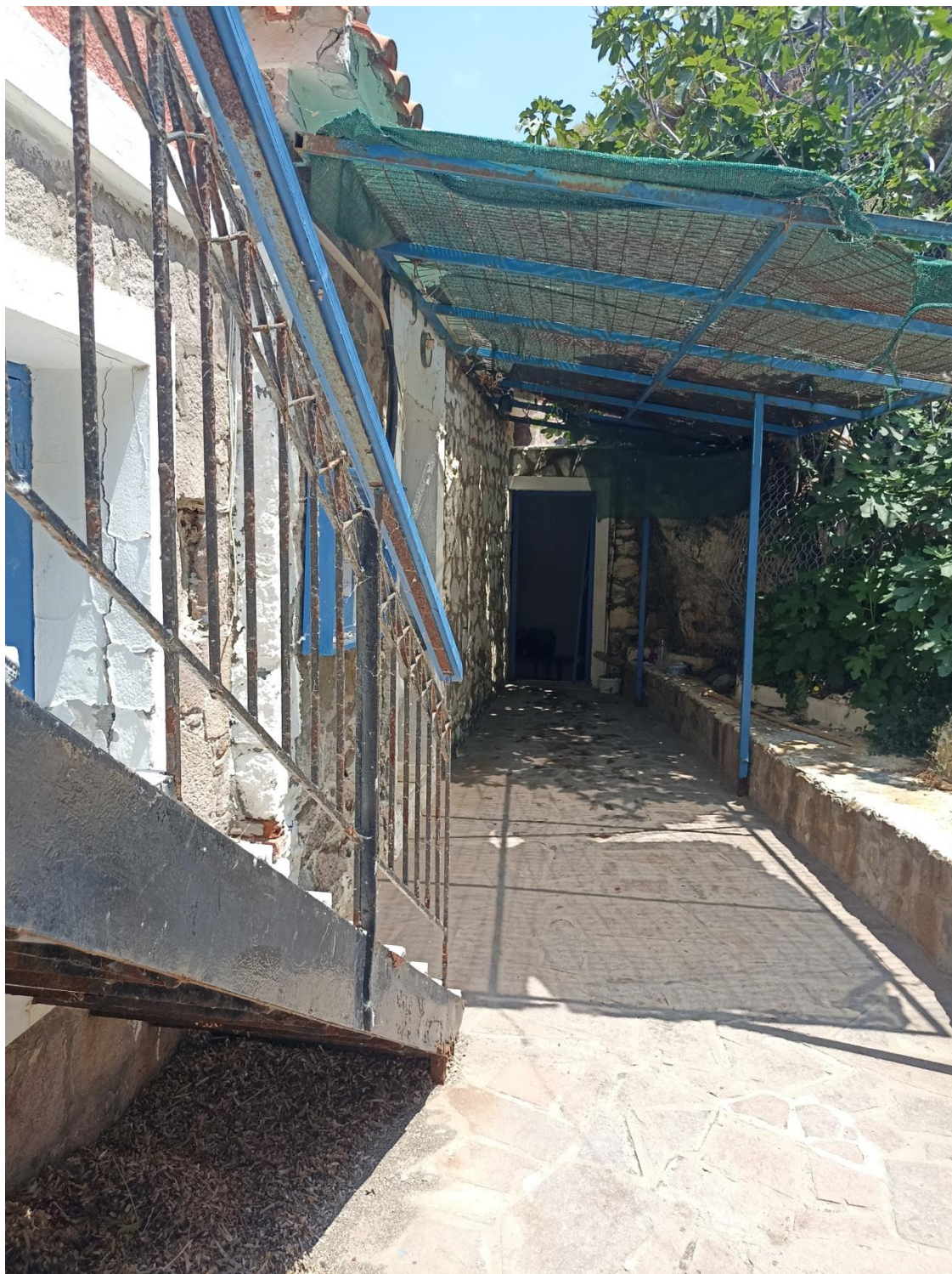
Η είσοδος στα δυο κτίρια
