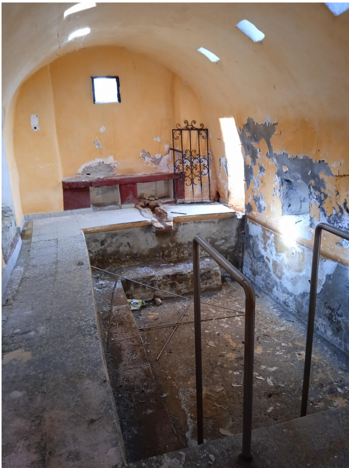
Ακίνητο Β, εσωτερικό λουτρών (δεξαμενή β)
