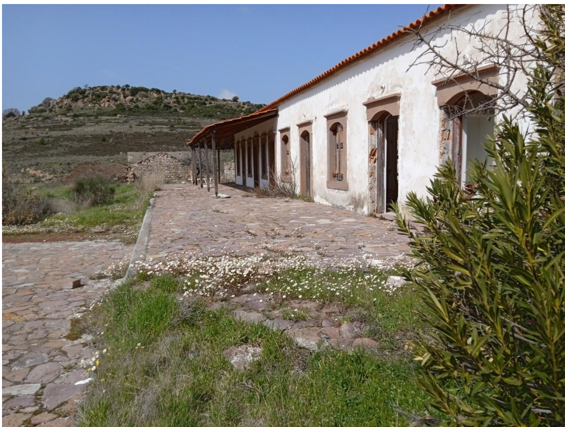
Ακίνητο Α, ξενώνας, Ν όψη
