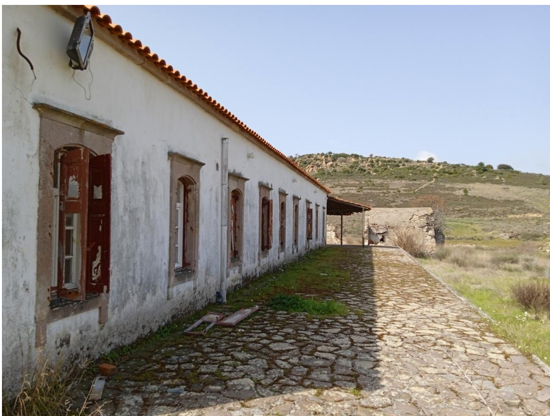
Ακίνητο Α, ξενώνας, Β όψη
