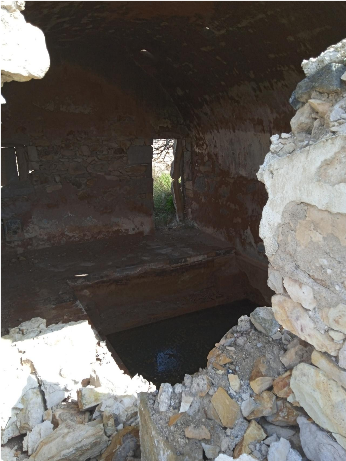
Ακίνητο Α, εσωτερικό λουτρού β
