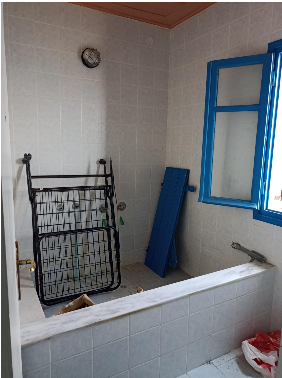
Ατομικό λουτρό ορόφου
