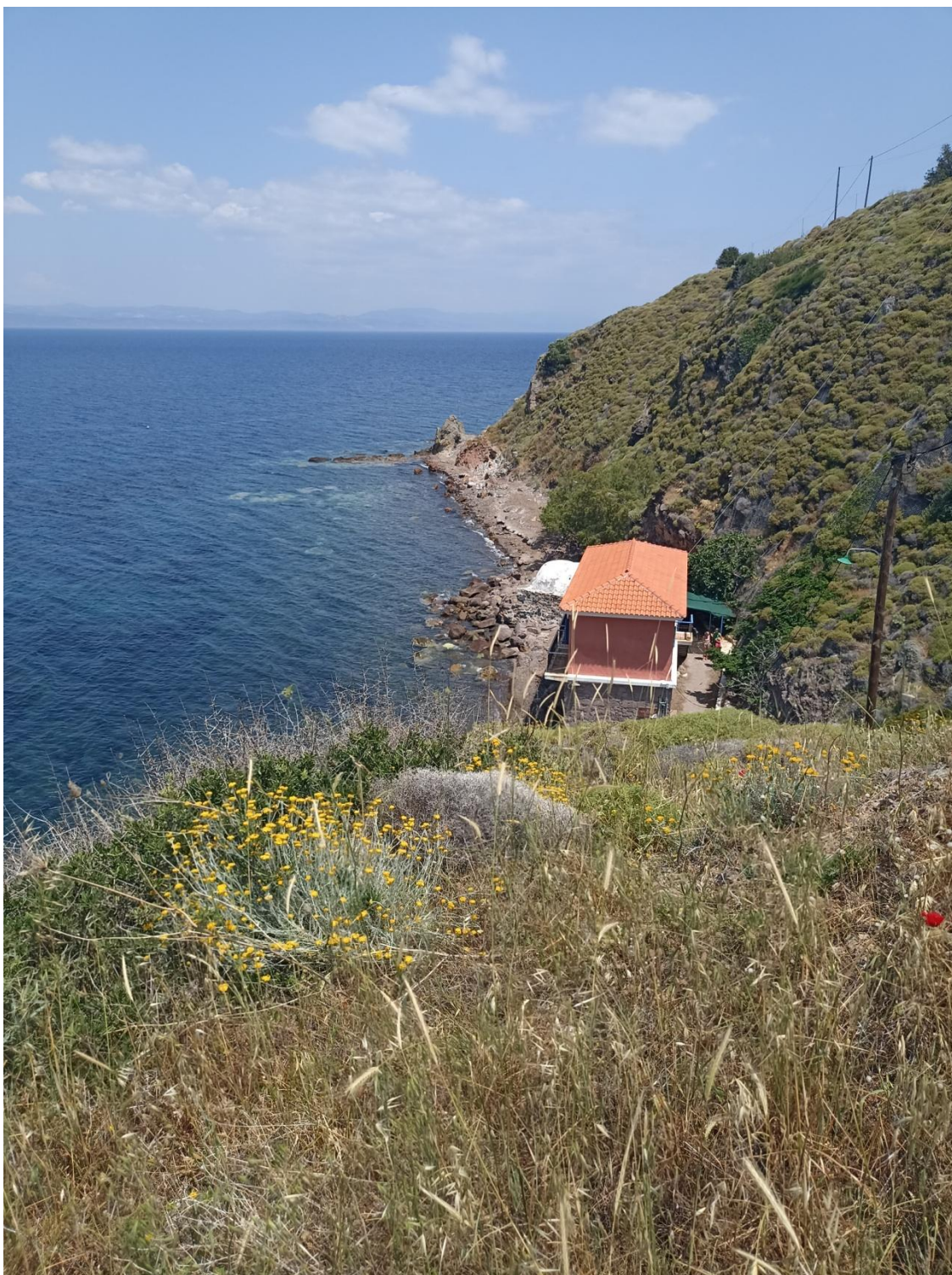
Οι εγκαταστάσεις από το δημοτικό δρόμο
